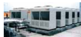
Модульная сборка чиллеров
